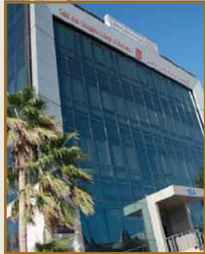
مبنى الكلية - عمان
